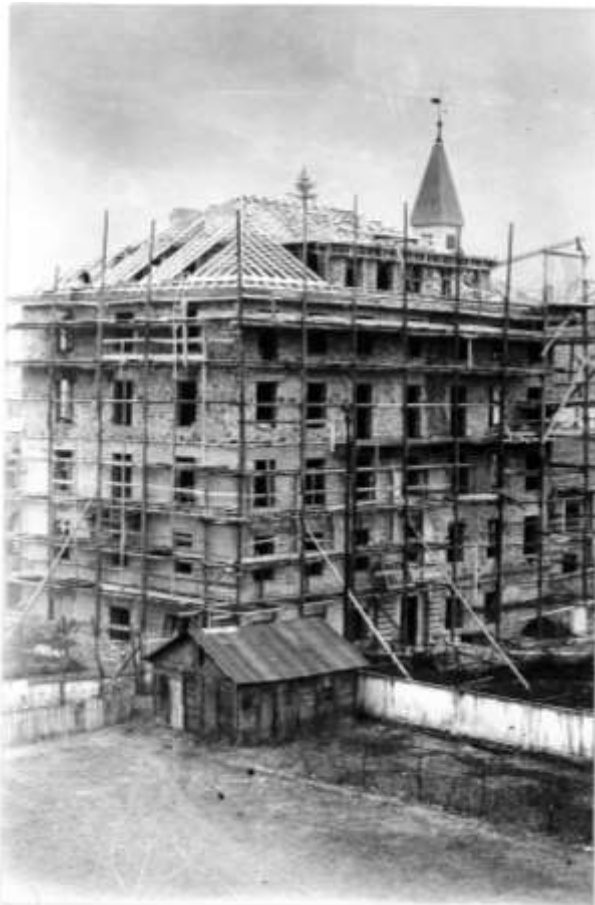
Das Antonianum beim Wiederaufbau 1947
